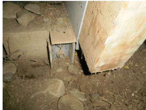
Betoniperustukseen liitetty c- profiili
